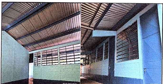
Foto 4: Pintura en muros interiores y exteriores finalizado.
